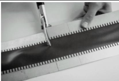
Отмерьте длину соединителя, равную периметру и отрежьте ее с запасом 5-6 см.
