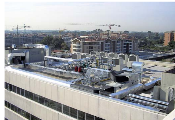
Замена чиллера. Подача холодной воды к фанкойлам.
