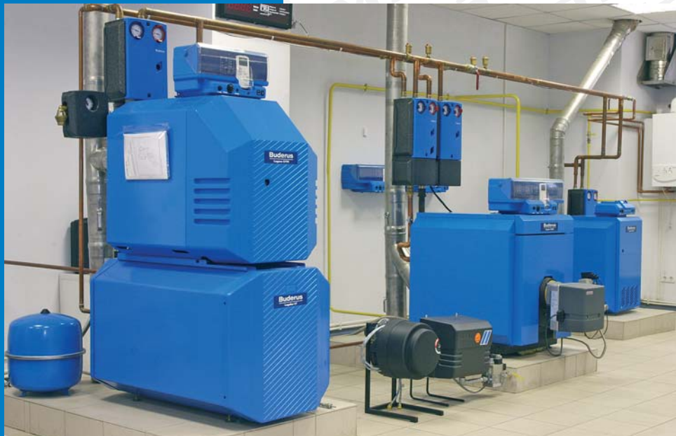
Учебный класс представителя Buderus в России, смонтированный специалистами группы Нимал. На переднем плане "двухэтажная" компоновка дизельного наддувного котла G115 - 28 кВт и бойлера LT 160 л.
