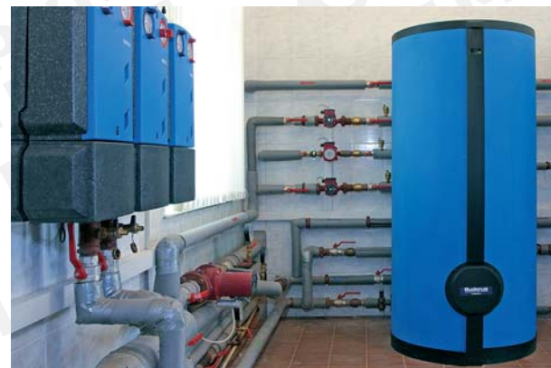
Бойлер SU 500 л., распределительный коллектор на 3 контура. Насосные группы.
